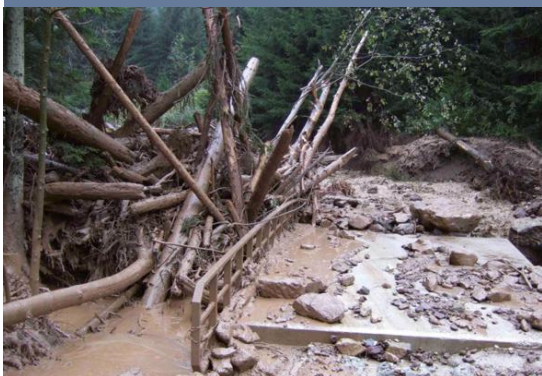
Bild 22: Verklauung an einer Brücke. © WLV, www.Biberberti.com .
