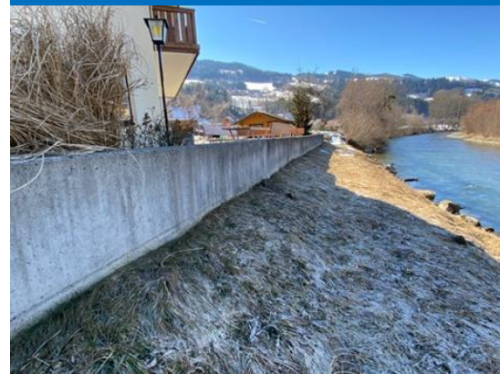
Bild 15: Beispiel eines technischen Hochwasserschutzes in der Gemeinde Michaelerberg-Pruggern. © Natalie Prügler
