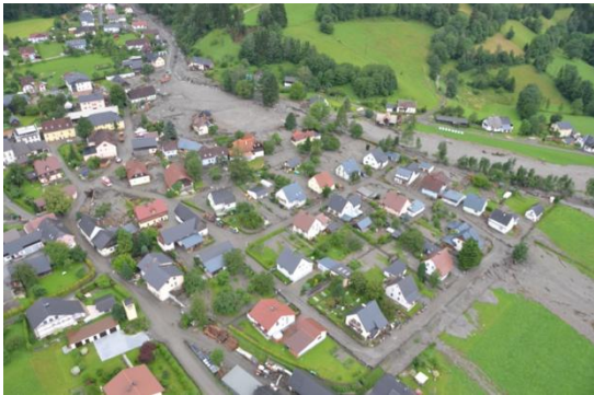
Bild 25: Vermurung eines Ortes. © Wildbach- und Lawinerverbauung (WLV), Forsttechnischer Dienst.
