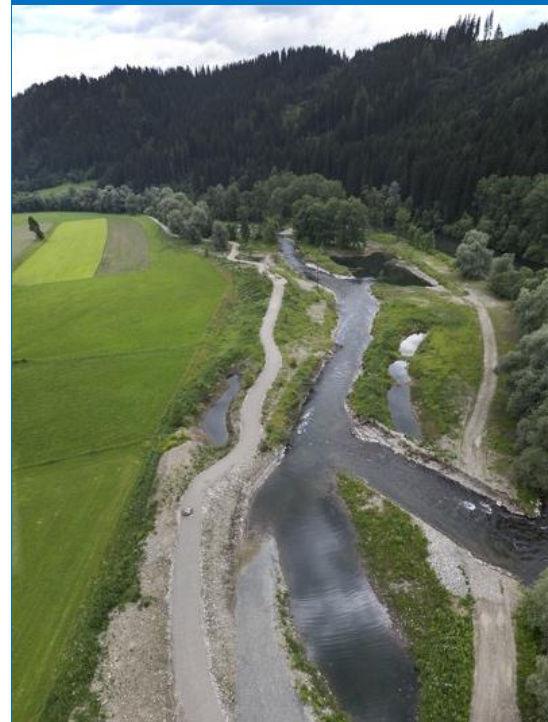
Bild 16: Beispiel eines natürlichen Hochwasserschutzes an der Mur. © Fachabteilung 14 Hochwasserrisiko- management, Land Steiermark.
